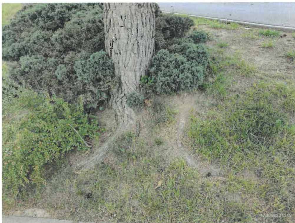
Obr. 3: Detail báze s vystupujícími kořeny, strom 1
