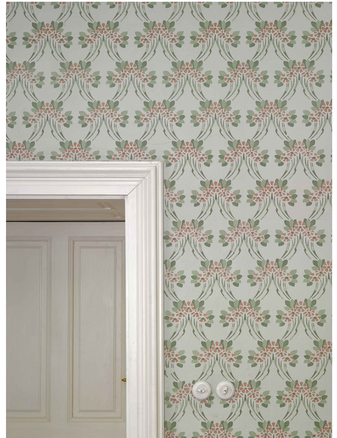
reference: Rekonstrukce a úprava rodného domu Josefa Hoffmanna v Brtnici © Atelier Brno, s.r.o.
