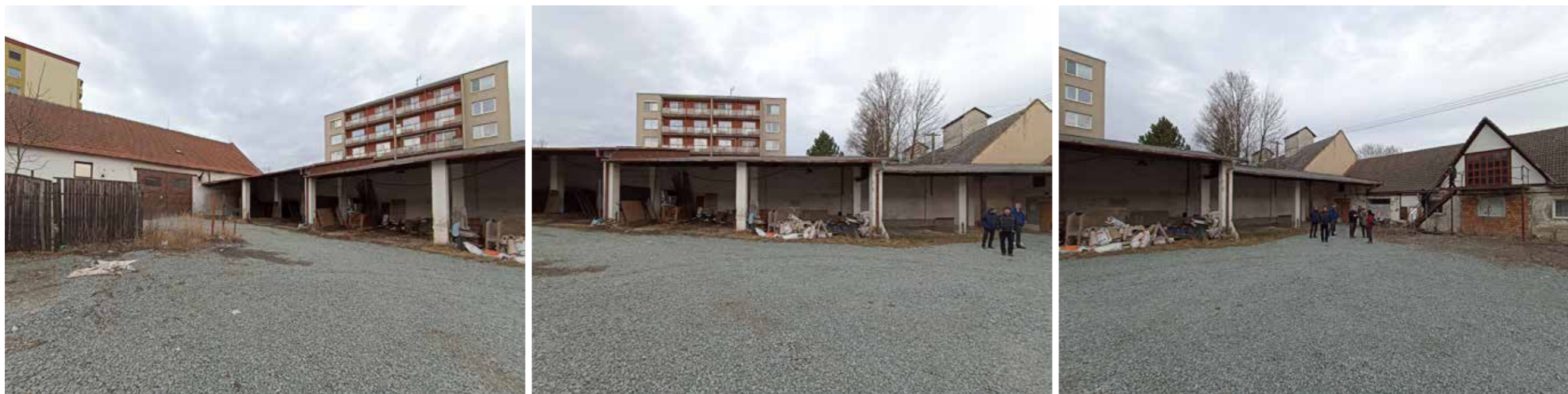
Fotodokumentace stávajícího stavu
