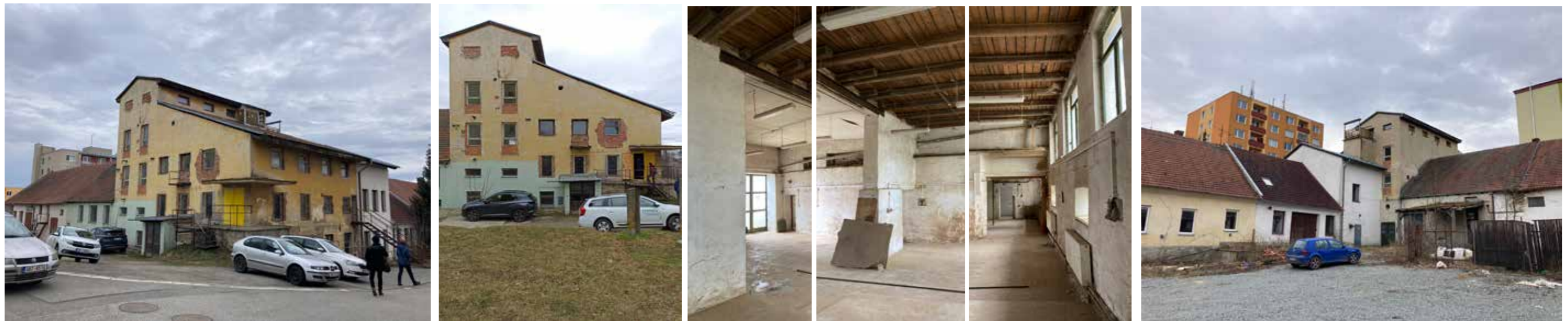
Fotodokumentace stávajícího stavu
