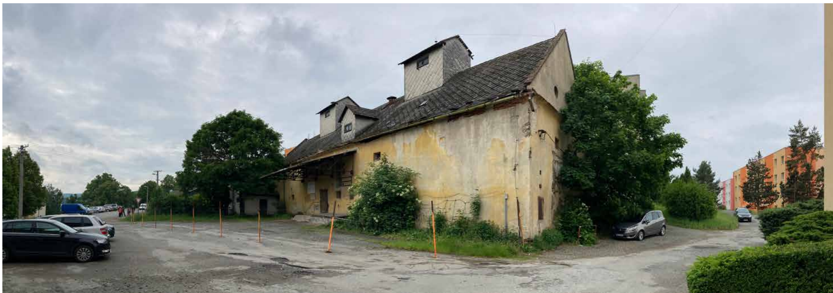
Pohled na stávající stav sýpky.
