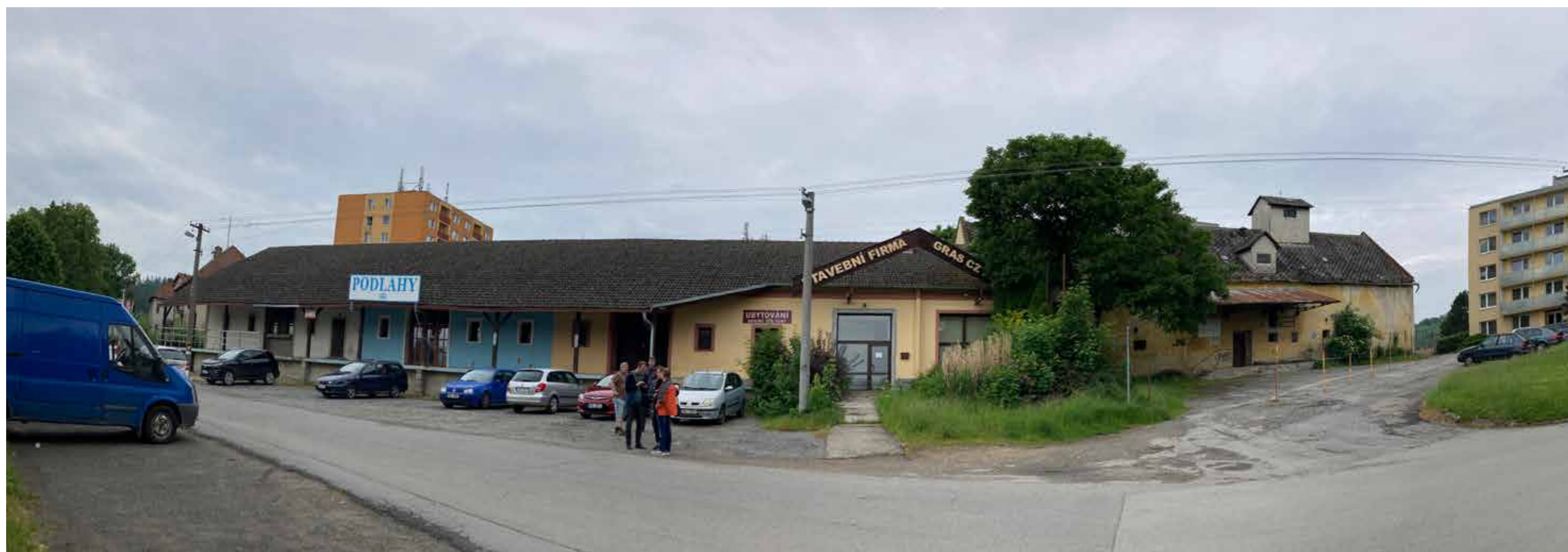
Pohled na stávající čelní fasádu Panského dvora
